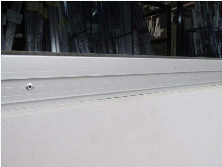
14) Coloque a capa de acabamento do perfil "U" de regulagem.
